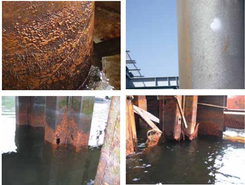
Рис. 1. Язвенная и сквозная коррозия морских причалов
