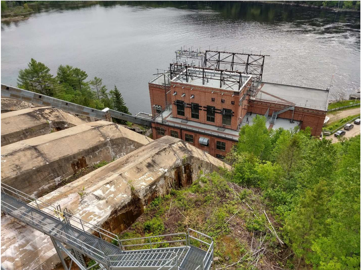
Рисунок 6 – Вид на здание ГЭС
