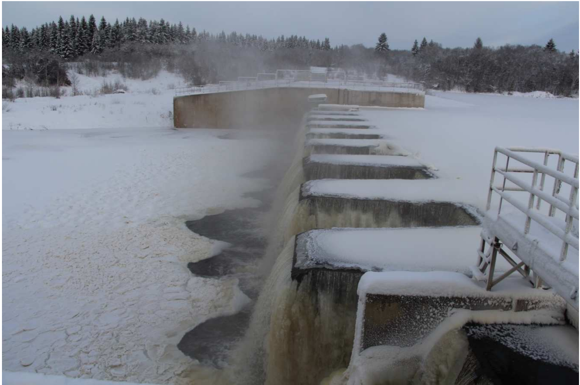
Рисунок 4 – Лабиринтный водосброс Хоробровской ГЭС зимой
