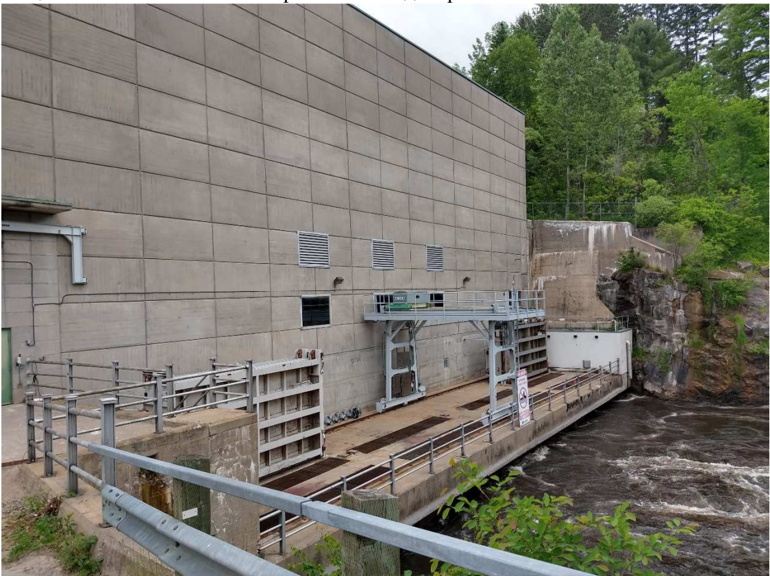
Рисунок 9 – Вид на здание ГЭС
